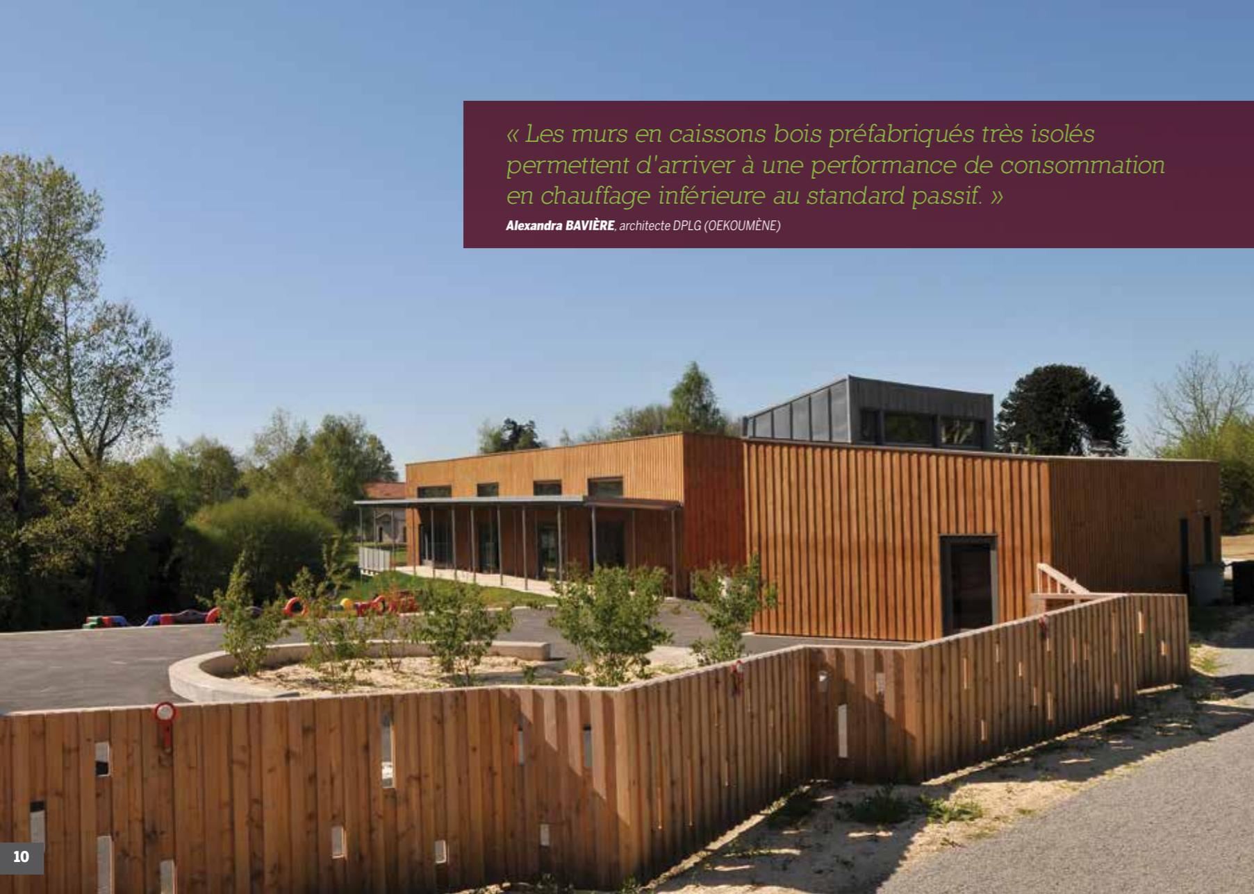
« Les murs en caissons bois préfabriqués très isolés permettent d'arriver à une performance de consommation en chauffage inférieure au standard passif. »
